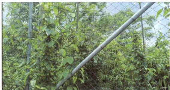
FOTO 5: Reparación de tubo hg y malla galvanizada
