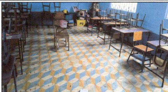
FOTO 1: Sustitución de piso cerámico
