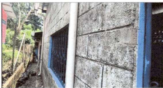
FOTO 3: Repello en muro Y Pintura en muros exteriores
