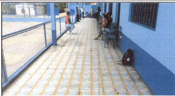
FOTO 2: Sustitución de piso cerámico
